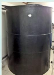
Conçue et réalisée localement pour Fresenius Medical Care (leader mondial produits et services en dialyse), la cuve de stockage d'une capacité de 3000 litres utile se compose de deux demi-cuves ayant été soudées sur site, pour répondre à la problématique du passage des portes.
